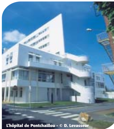
L'hôpital de Pontchaillou - © D. Levasseur
